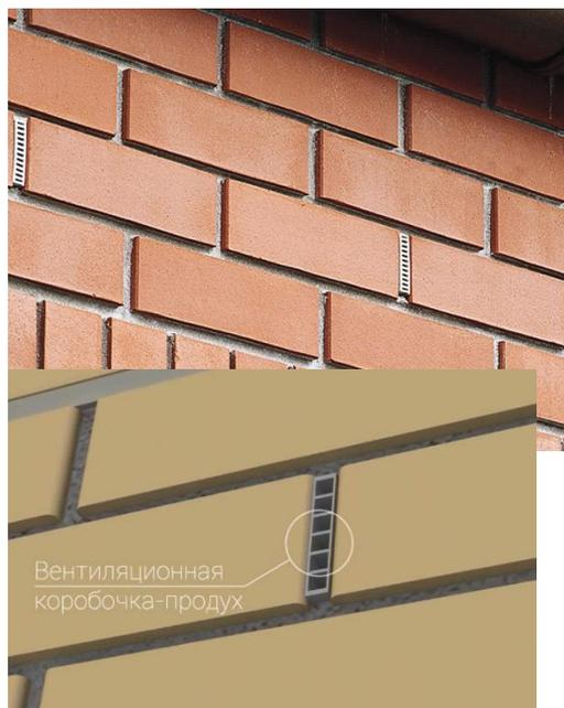
**Отсутствие** вентиляции в конструкциях кирпичного фасада, приводит к **образованию конденсата** на внутренней поверхности лицевого кирпича либо на внешней рядового.
