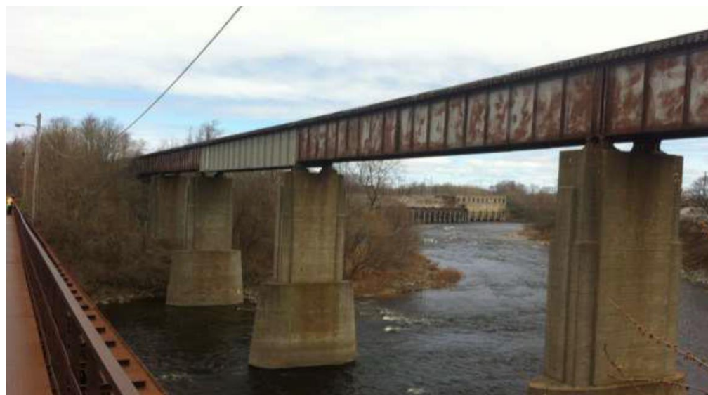
Мост Grasse River Bridge, г. Массена, шт. Нью-Йорк (США), 1946 год
