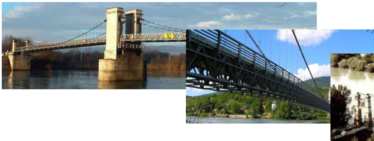
Самые длинные алюминиевые мосты в мире через р. Рона (Франция), длина пролетов от 134 до 177 м. 1970 годы постройки
