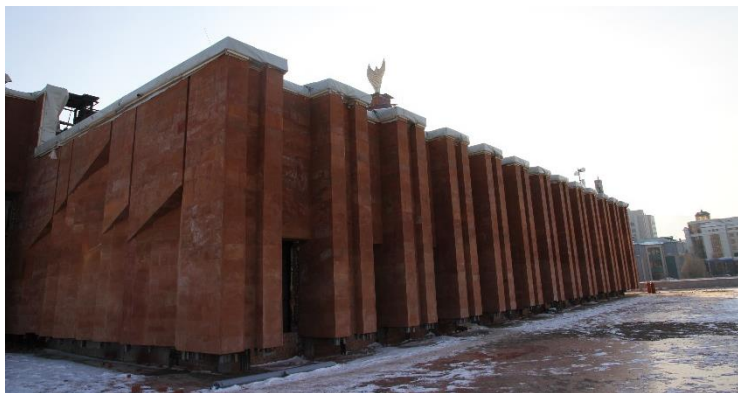
Реконструкция здания НКЦ «Казань» под здание Национальной библиотеки Республики Татарстан
