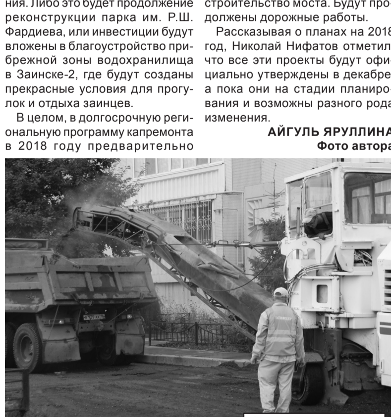
Фрезерование дорог
