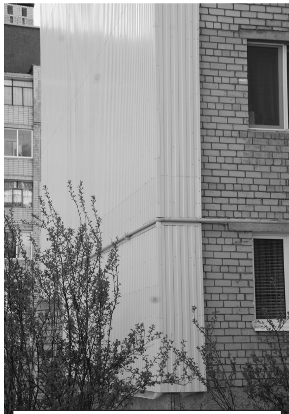
Утепление торцевой стены дома 1/16 по пр.Победы
