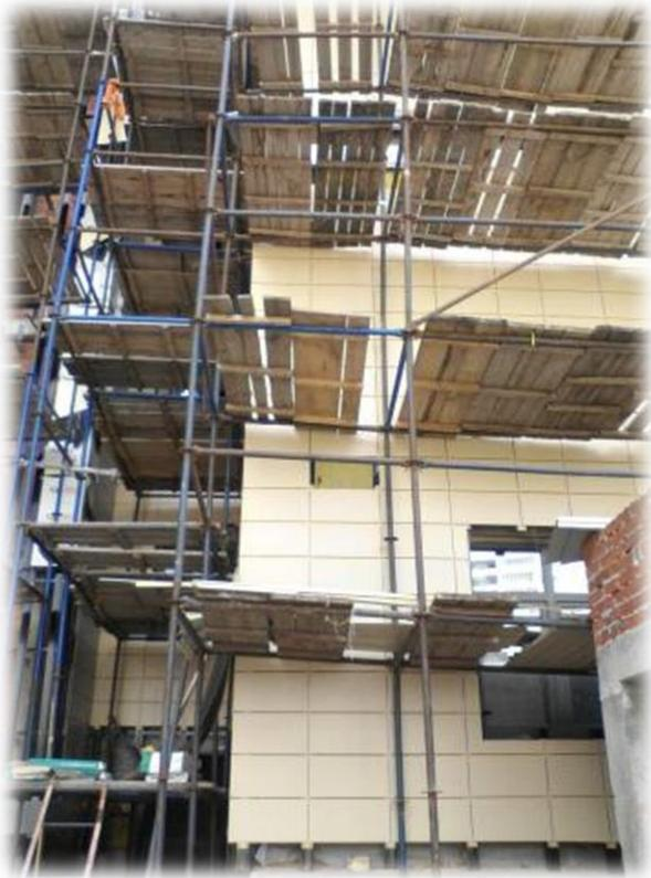
Средства подмащивания имеют рабочие настилы с зазором между досками более 5 мм, а при расположении настила на высоте более 1,3 м - отсутствуют ограждения
