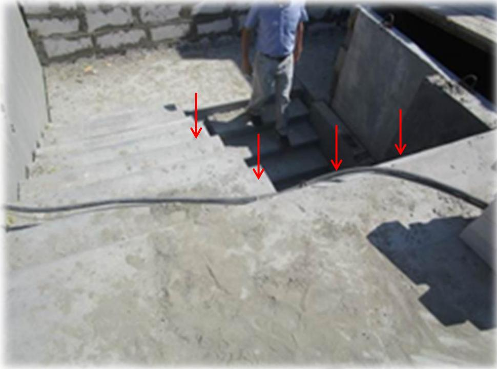
Отсутствуют защитные (страховочные) ограждения на рабочих местах, расположенных на высоте более 1,3 м
