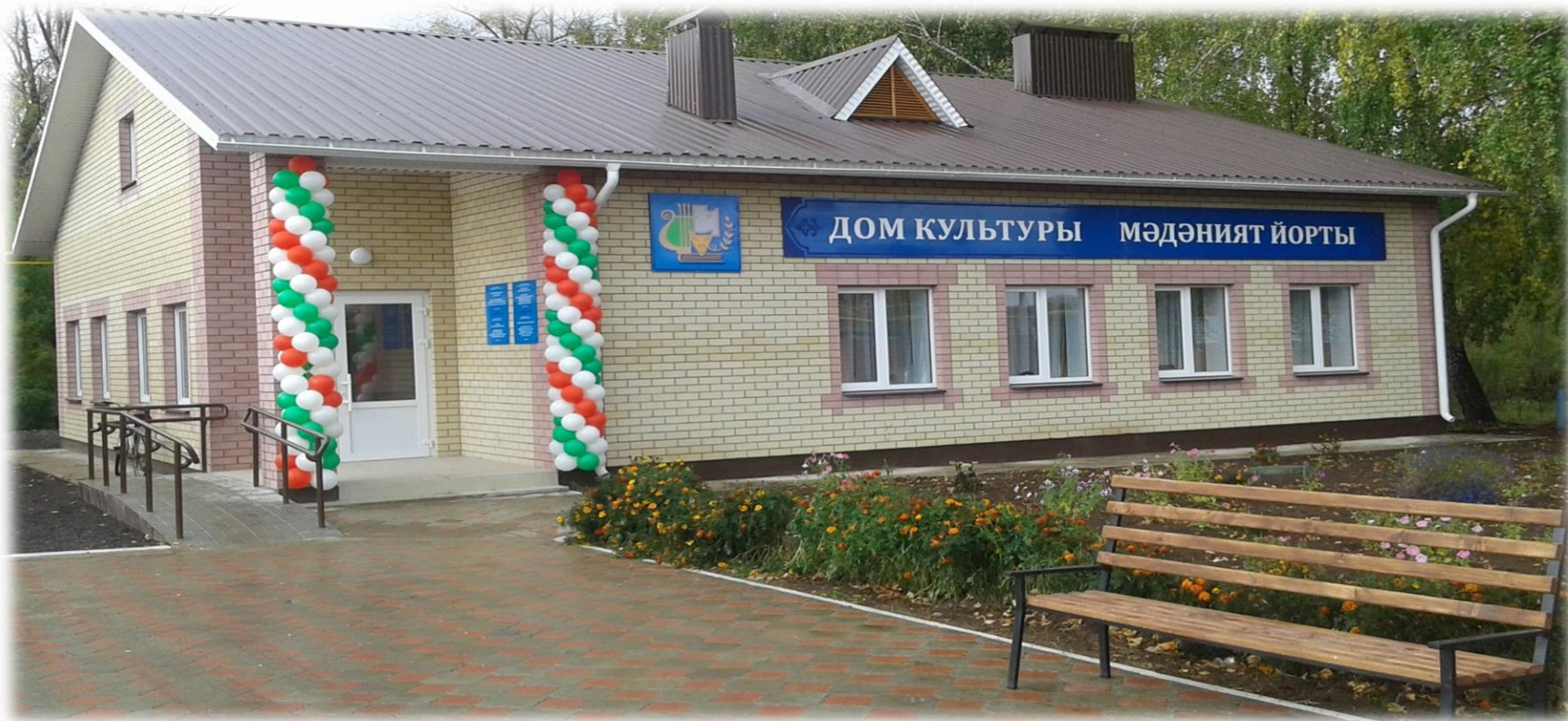
Менделеевский, с.Тойгузино Подрядчик: ООО "Строитель"
