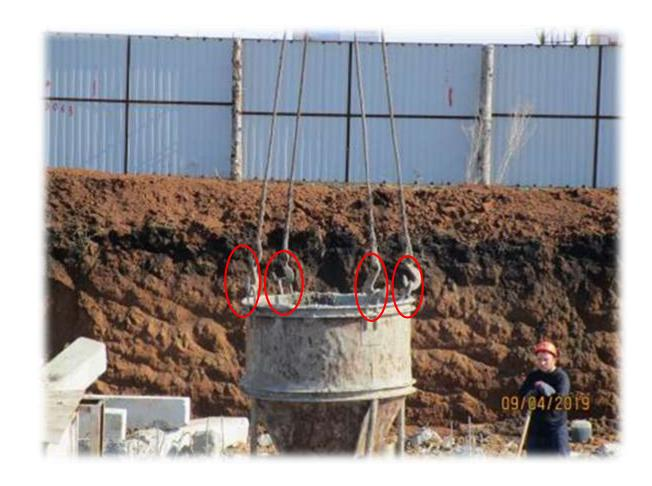
Грузовые крюки не снабжены предохранительными замыкающими устройствами, предотвращающими самопроизвольное выпадение груза
