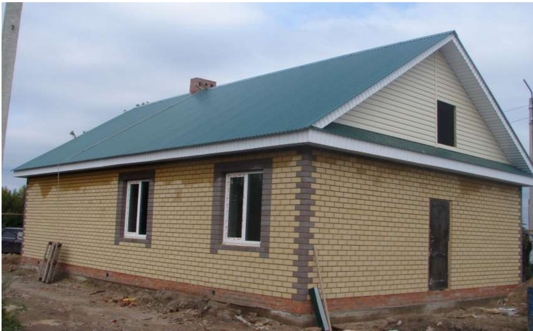
Сабинский район, с. Шемордан, ул Лермонтова д.35 Подрядчик - ООО «Инвестстройхолдинг».
