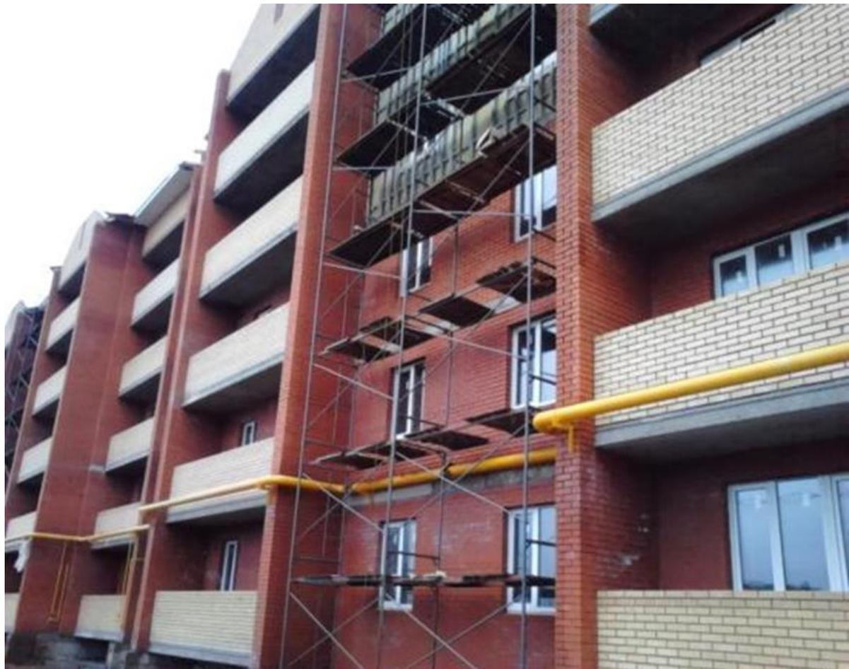
Рабочие настилы лесов имеют зазор между досками более 5 мм
