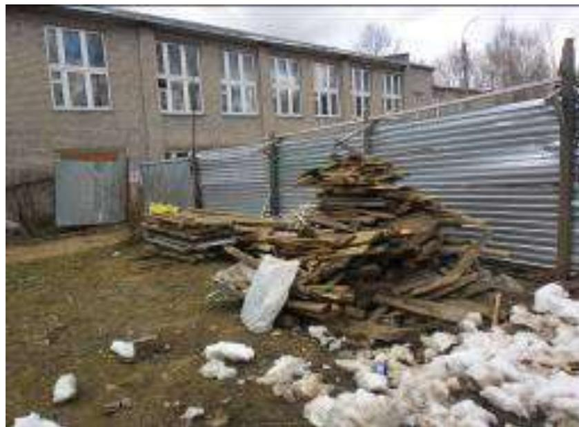
**сброс и скопление отходов строительного производства на грунтовой поверхности, несвоевременный вывоз строительного мусора; отсутствие специализированного контейнера под мусор - нарушение СанПиН 2.1.7.1322-03**
