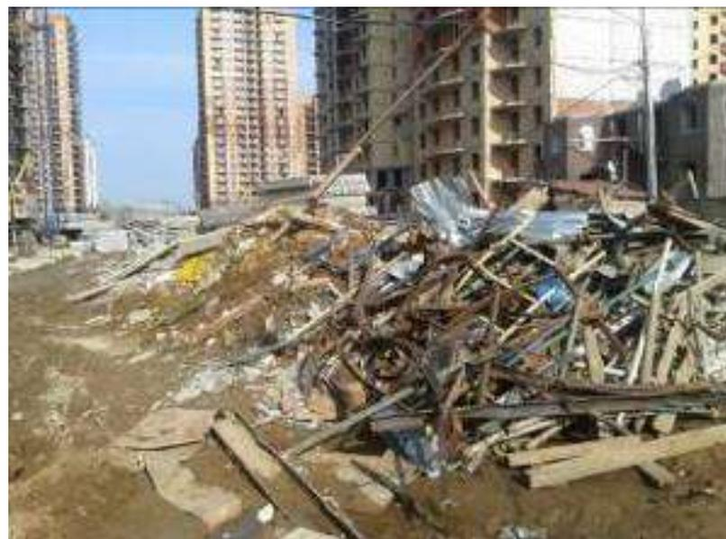
размещение отходов строительства на грунтовой поверхности –
