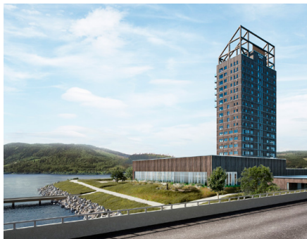
Самое высокое деревянное здание в мире — Mjøstarnet высотой 85,4 м — построено в 2019 году в Норвегии
