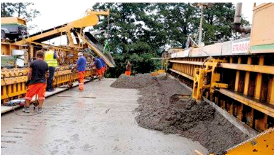
Реконструкция старого автобана в Германии, покрытие — бетон
