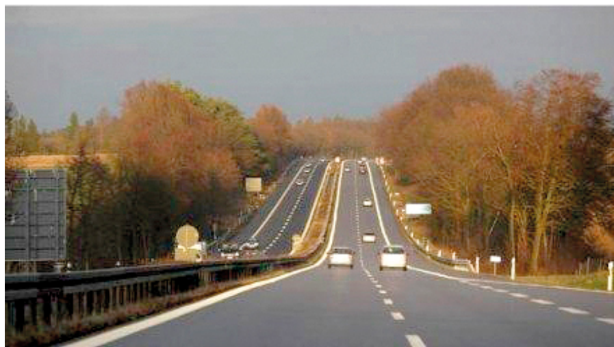
Автобан Дрезден — Берлин, бетонное покрытие
