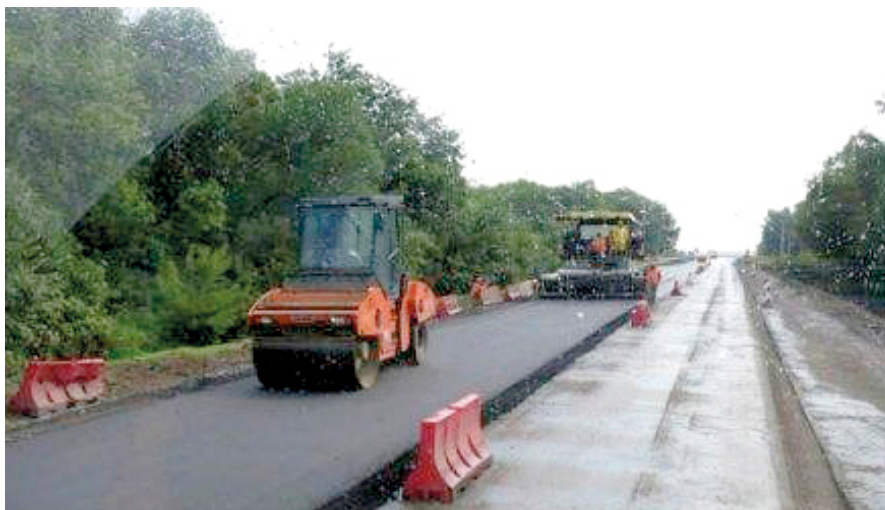
Трасса Тамбов — Волгоград, на старый бетон — новый асфальт
