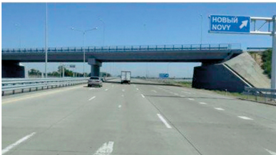
Автотрасса в Казахстане, покрытие — бетон
