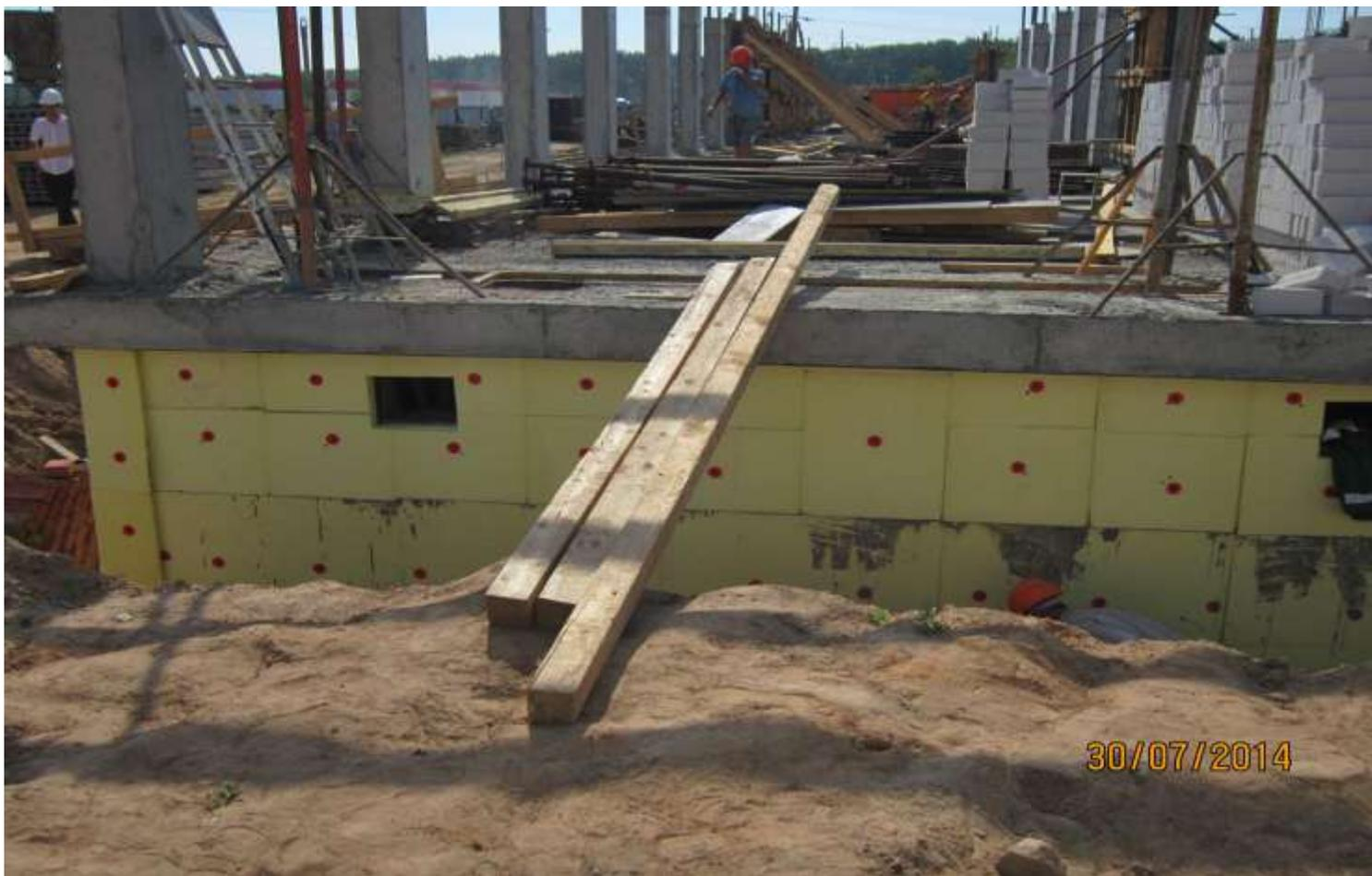
Для перехода через траншею установлены незакрепленные брусья
