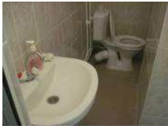
Высота установки санитарных приборов, водоразборной арматуры в санузлах и у входа в столовую от уровня чистого пола не соответствует требованиям СНиП 3.05.01-85 п.3.15, СП 73.13330-2012 п. 6.2.1. 6.3.4, СП 30.13330.2012 п. 8.4.5.
