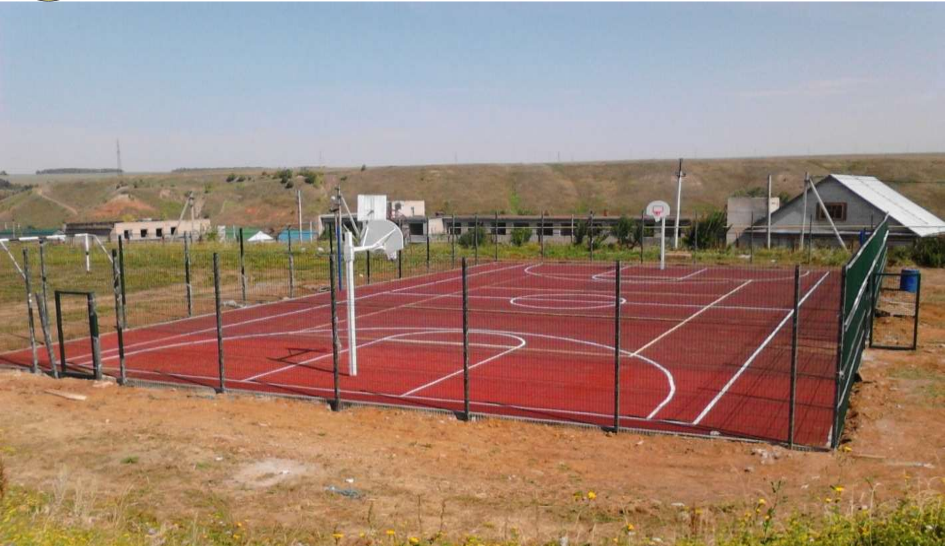
Менделеевский муниципальный район, с. Ижевка Подрядчик: ООО «Строймонтаж»
