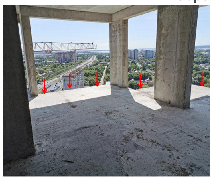
Отсутствуют защитные (страховочные) ограждения на рабочих местах, расположенных на высоте более 1,3 м
