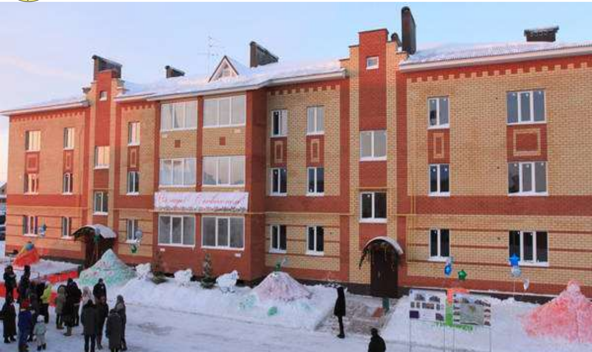
г.Лаишево, 24 кв. ж/д поз.8 по ул. Сайдашева-Юбилейная подрядчик ООО «НовоСтрой»
