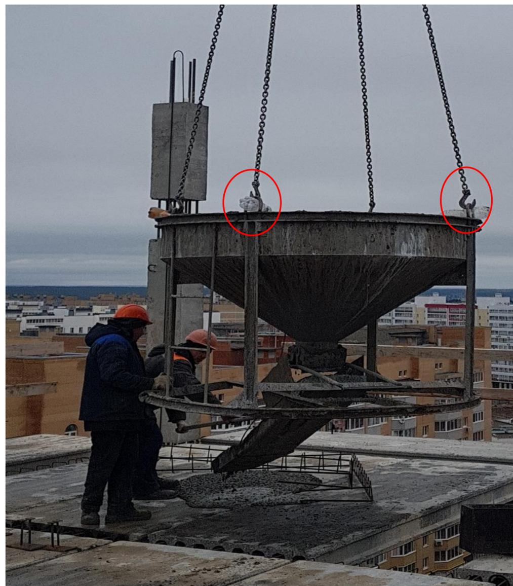
**Грузовые крюки не снабжены предохранительными замыкающими устройствами, предотвращающими самопроизвольное выпадение груза**
