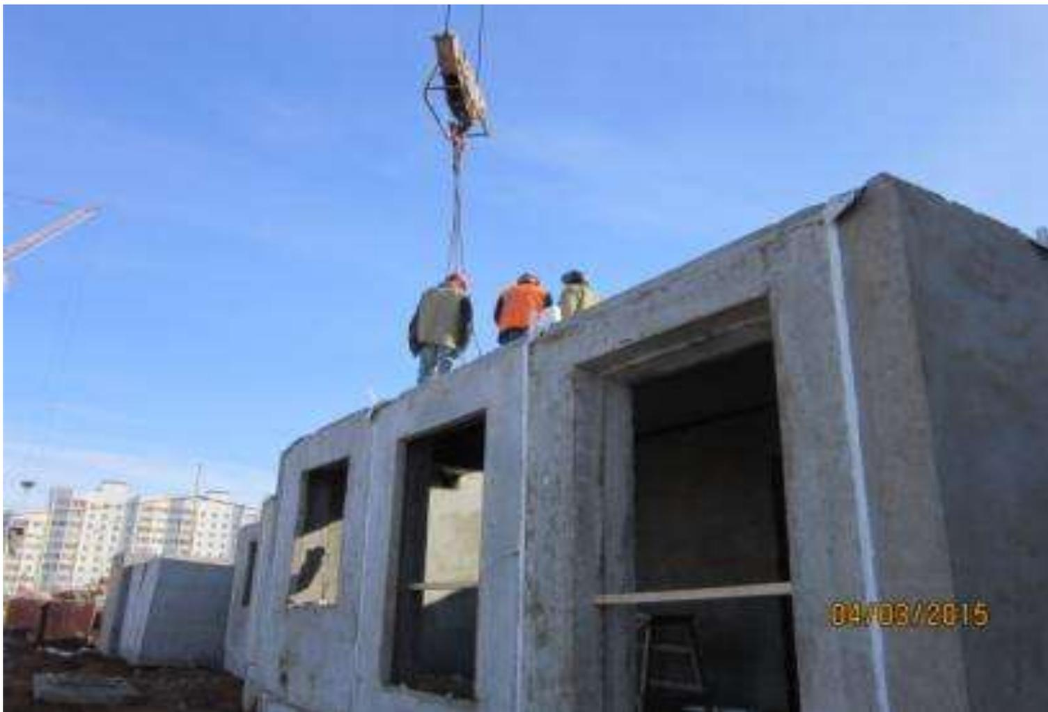
У рабочих отсутствуют предохранительные пояса при работе на высоте
