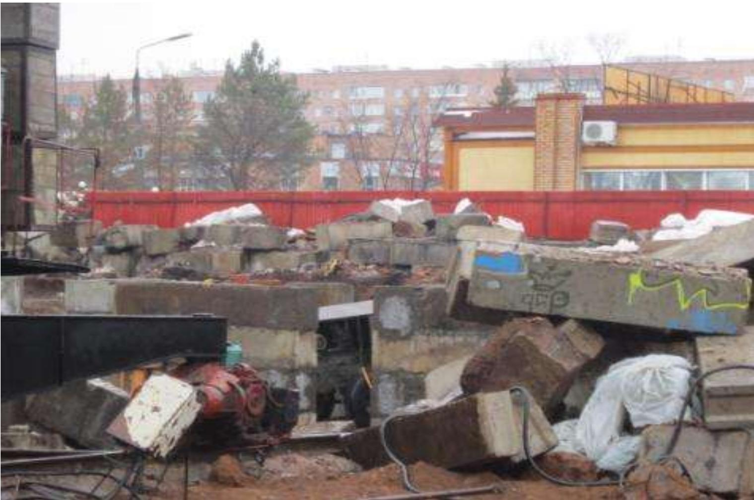
Проезды и проходы загромождены строительными материалами и конструкциями
