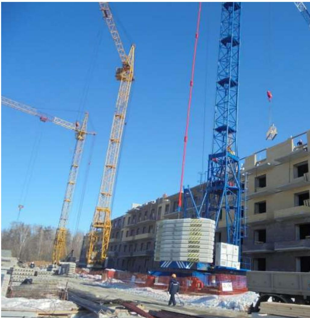
Опасные зоны работы крана выделены, установлены защитные ограждения и знаки безопасности, рабочие обеспечены спецодеждой и средствами защиты
