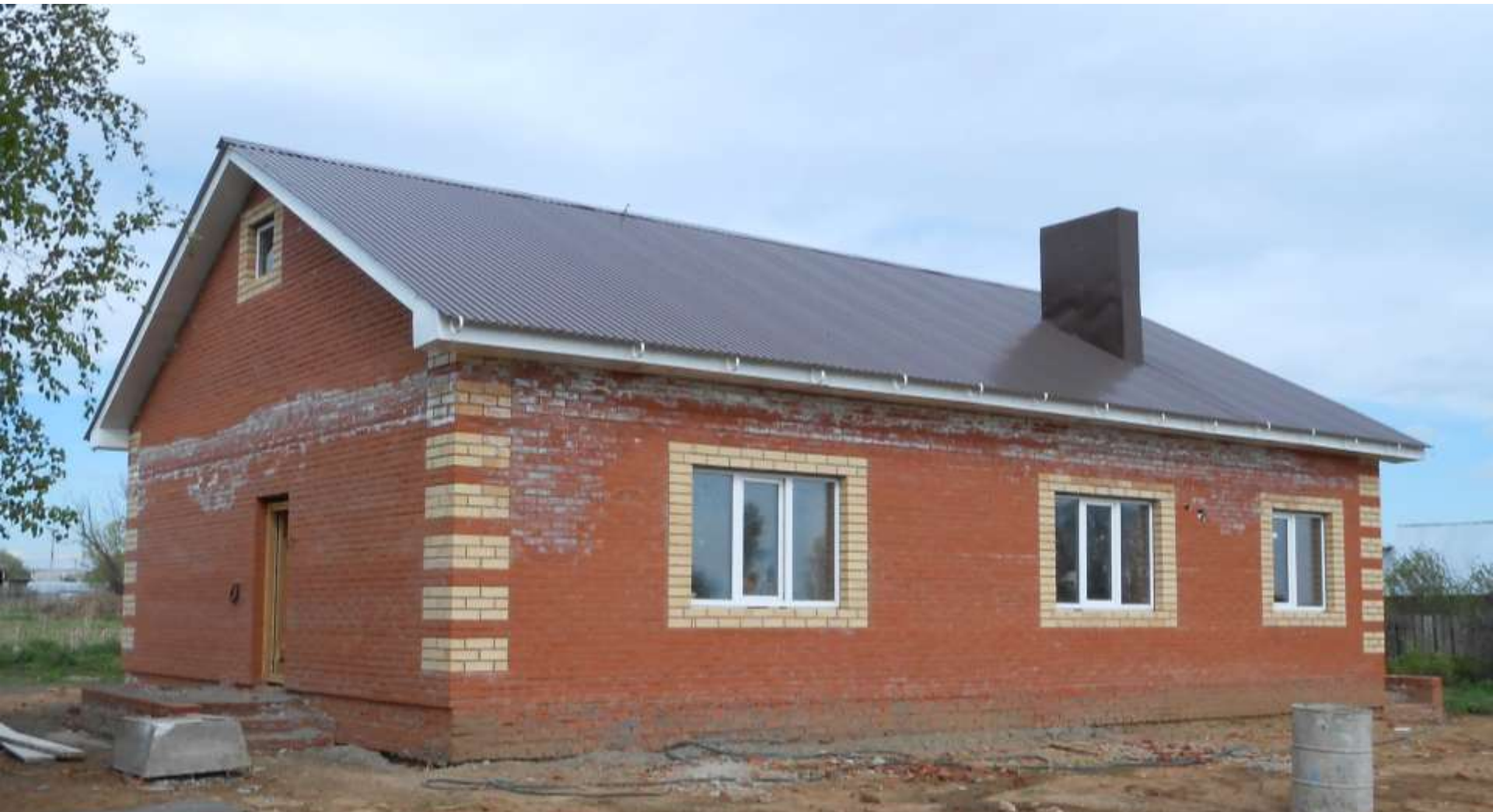
Мамадышский район , с.Катлыш Подрядчик - ЗАО «Стройсервис»
