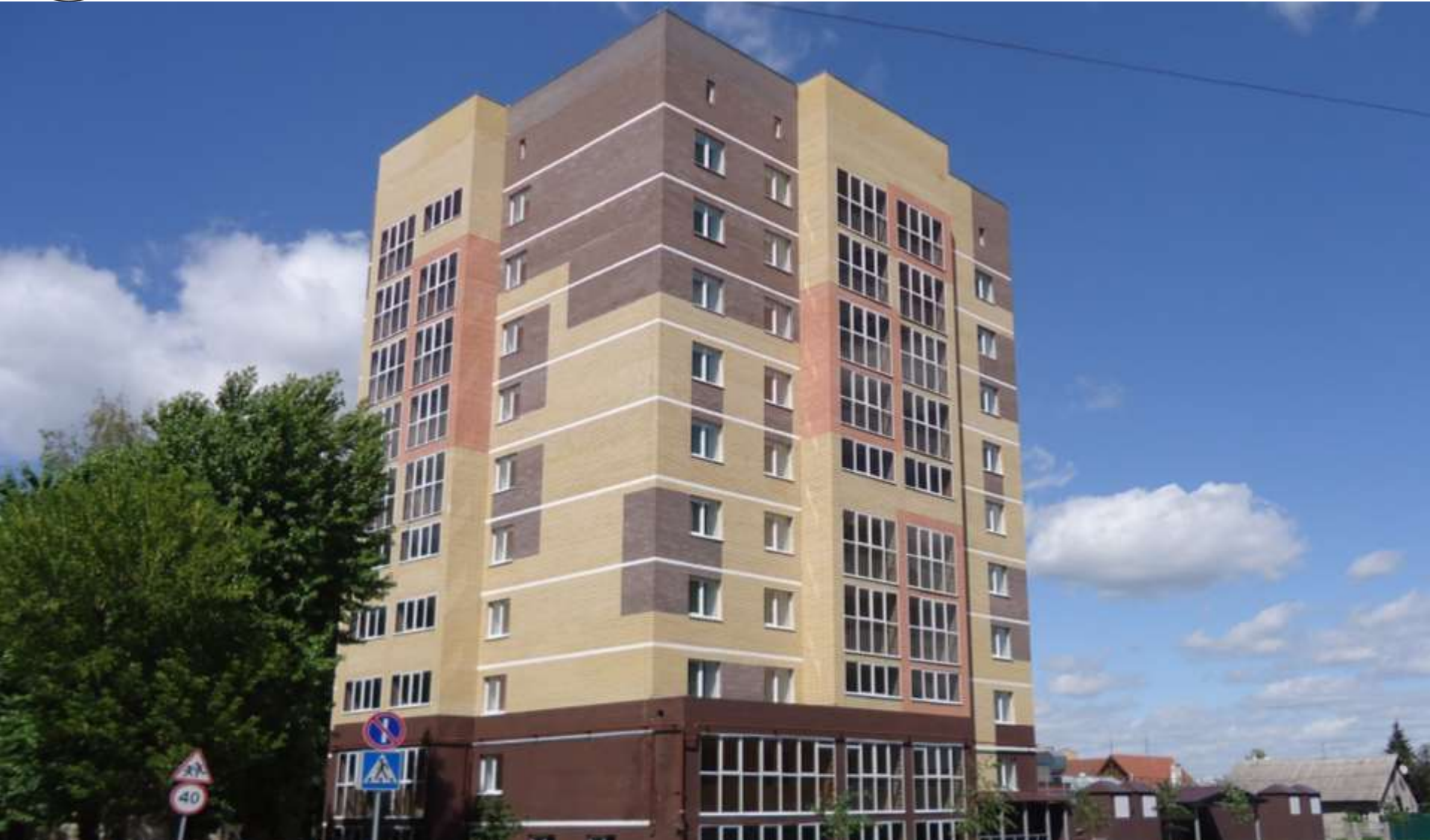
г. Казань 44-кв. жилой дом по ул. Журналистов подрядчик ООО «Ак Таш»
