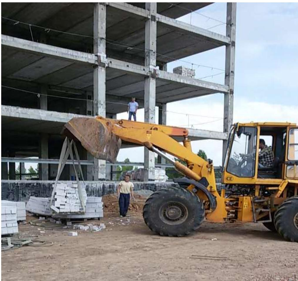
Работники не обеспечены спецодеждой, подъем строительных материалов производится техникой, не предназначенной для данного вида работ
