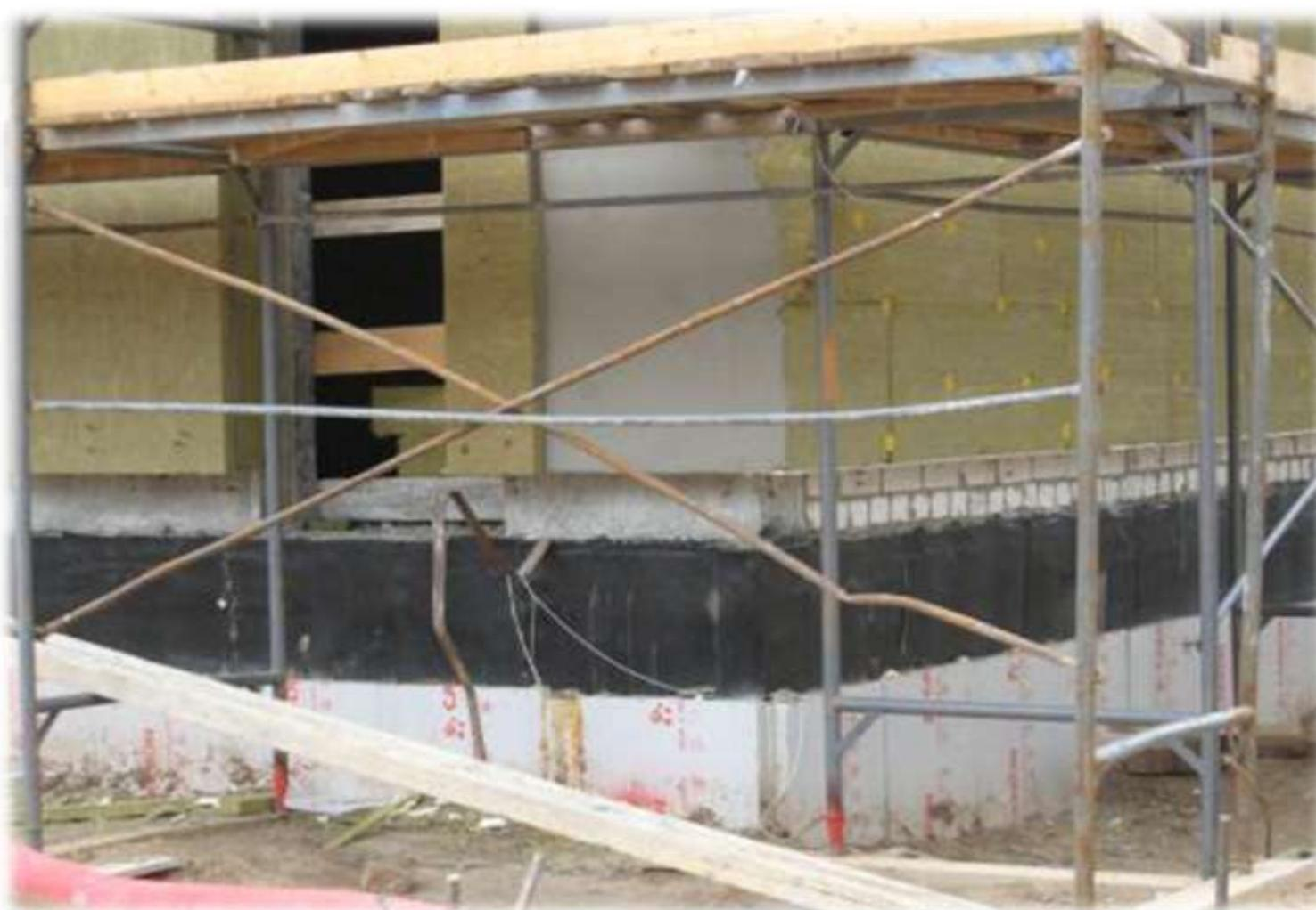
Строительные леса имеют деформированные элементы и крепление к парапету
