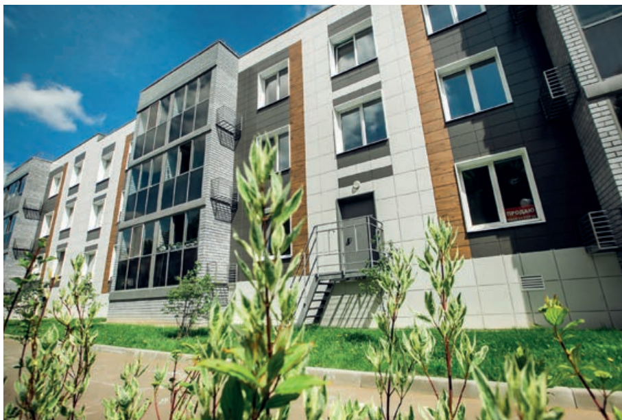
В ЖК «Царево Village» под Казанью расположен первый в регионе многоквартирный дом с альтернативными источниками энергии. Электричество для домашних нужд вырабатывается солнечными панелями, отопление и горячее водоснабжение — от геотермального теплового насоса и солнечных коллекторов
