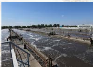
Реконструкция биологических очистных сооружений канализации Казани
