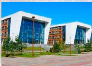
Строительство жилых корпусов Университета Иннополис
