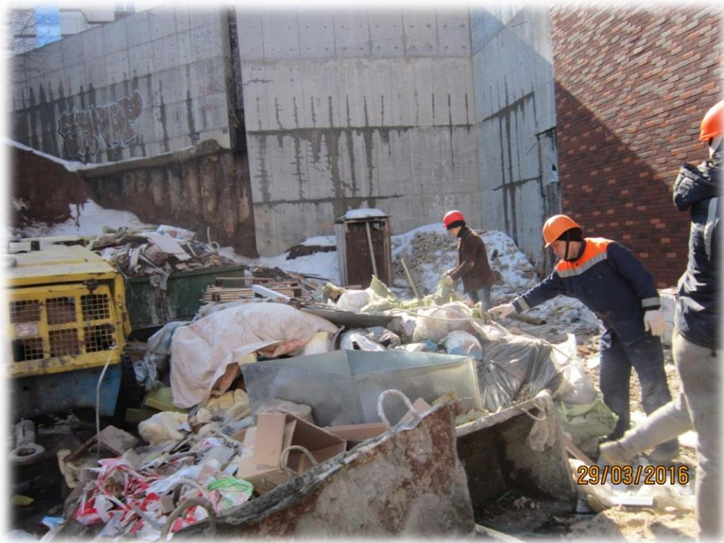
Не обеспечивается вывоз строительных отходов со строительной площадки
