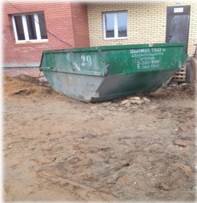
Емкости для временного хранения отходов расположены на почве без водонепроницаемого основания
