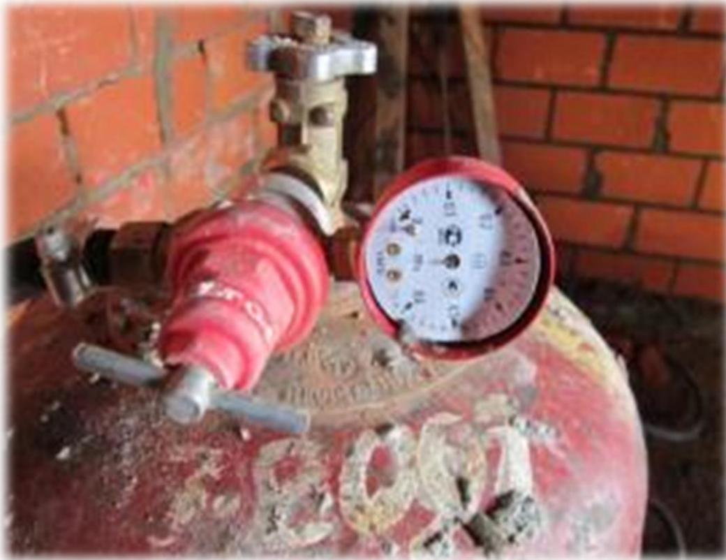
Газовый баллон под давлением эксплуатируется с неисправным манометром
