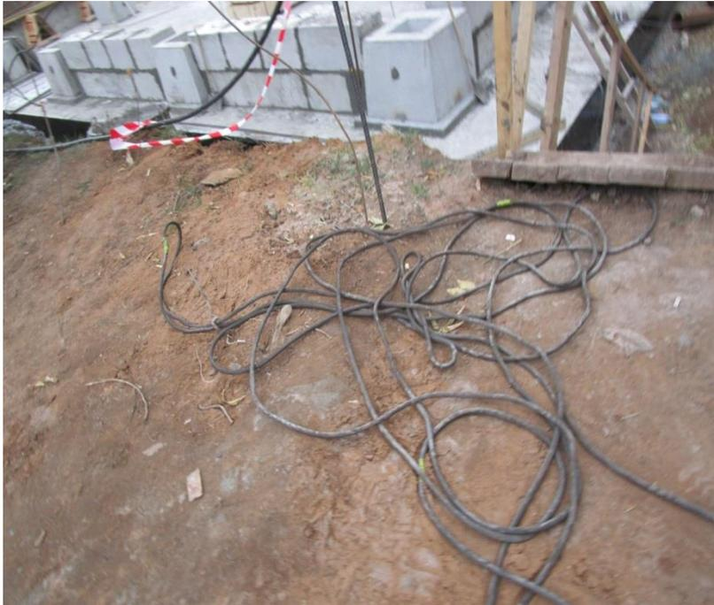
Нарушение требований безопасности к местам производства сварочных работ (не приняты меры против повреждения изоляции и соприкосновения с водой сварочных проводов)
