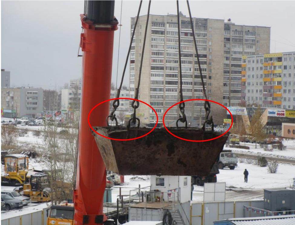
Грузовые крюки не снабжены предохранительными замыкающими устройствами, предотвращающими самопроизвольное выпадение груза
