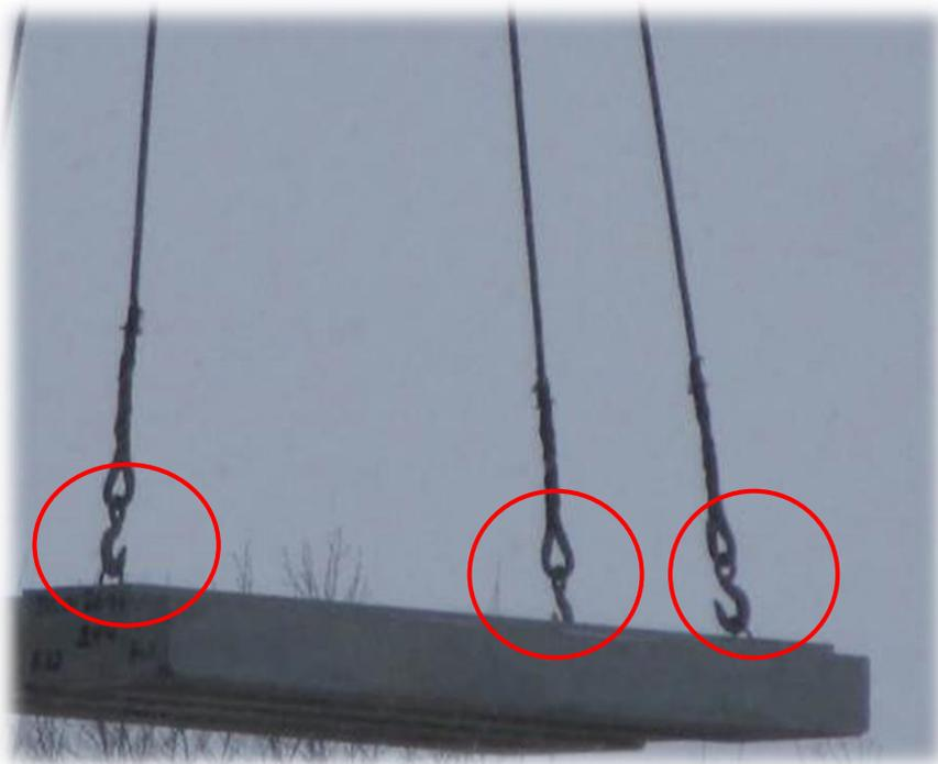
Грузовые крюки не снабжены предохранительными замыкающими устройствами, предотвращающими самопроизвольное выпадение груза
