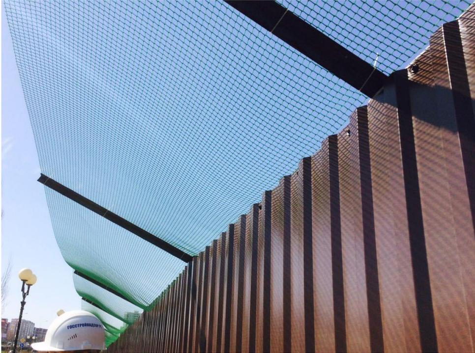
Конструкция защитного козырька временного ограждения строительной площадки выполнена из синтетической сетки
